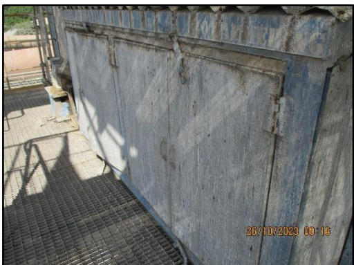
ภาพที่ 2.3 Casing หุ่นชุด Hammering Equipment ในหม้อไอน้ำ
